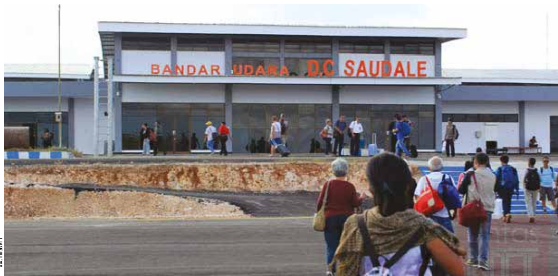
Bandara D.C Saudale, di Pulau Rote. Rakyat di Pulau Rote juga bisa merasakan manfaat pembangunan infrastruktur, lancarnya konektivitas
