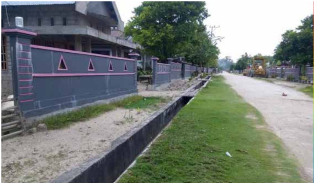
pembangunan drainase desa di Kabupaten Kepulauan Talaud dengan menggunakan dana desa untuk pengerjaannya
