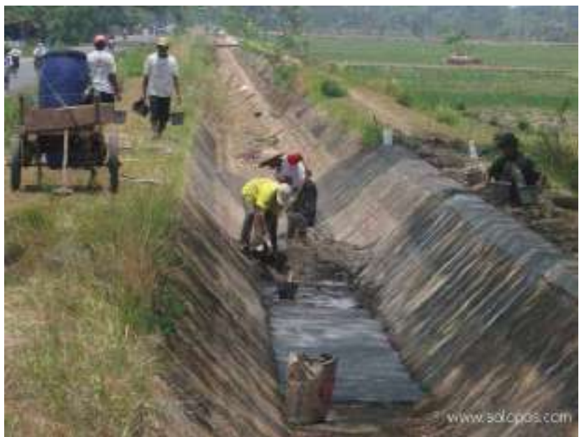
sejumlah warga memperbaiki saluran irigasi secara swadaya
